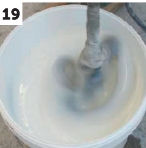
Homogenização do verniz de poliuretano MICROARTAD 50
