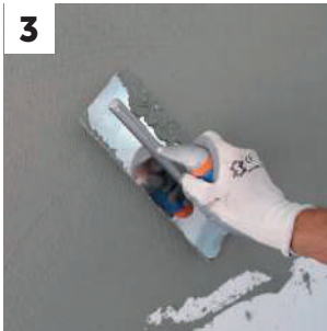
Aplicação da primeira camada de MICRO ART MC 01
