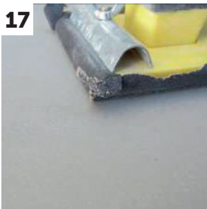
Lixagem após secagem do selante
