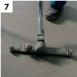
Limpeza entre camadas após lixagem
