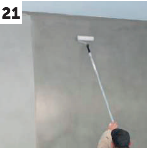
Após secagem da 1ª demão de MICROARTAD50 , aplicação da 2ª camada com rolo de pelo curto
