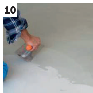
10 Aplicação da última camada de MICRO ART MC 02
