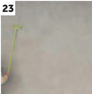
Limpeza final do sistema
