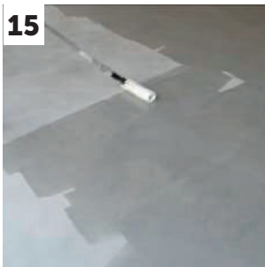
Aplicação do MICROARTAD 92 com um rolo de pelo curto microfibras
