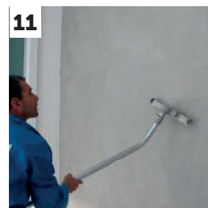
11 Limpeza antes da colocação do protector
