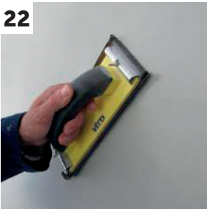
Lixagem final do sistema
