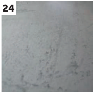
Aspetto final do sistema com o protetor de poliuretano MICROARTAD50
