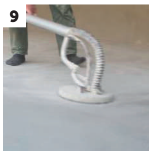
9 Lixagem entre camadas e posterior limpeza
