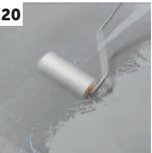
Aplicação da primeira demão de verniz de poliuretano MICROARTAD 50
