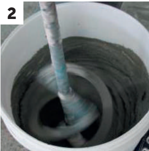
Mistura dos componentes do MICRO ART MC 01
