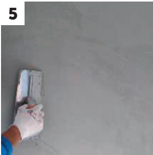
Aplicação da segunda camada de MICRO ART MC 01
