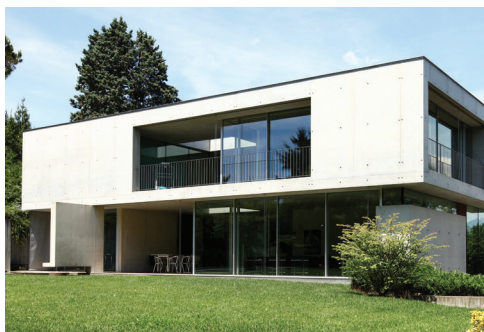
Elemento arquitetónico em betão branco
