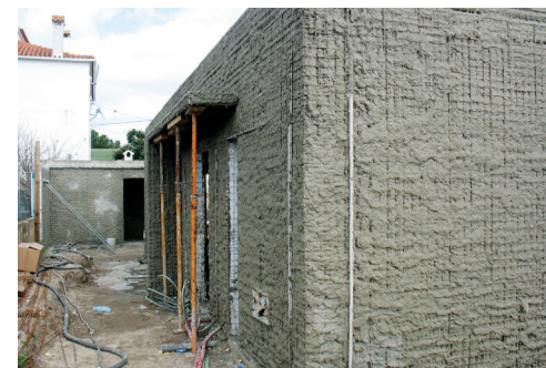
Aplicação de BETÃO-S PROJ em moradia
