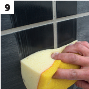
Limpeza do excesso de argamassa
