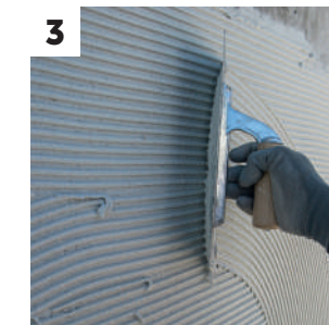
3 Regularizar a superfície obtida com pente ou talocha denteada
