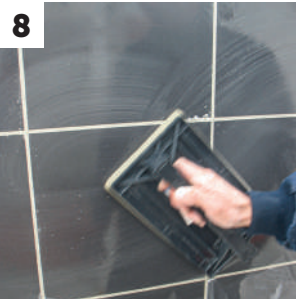
Limpeza de argamassa
