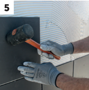
Pressionar a peça contra o suporte com o auxílio de um maço de borracha
