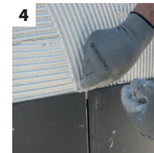
4 Juntas de colocação
