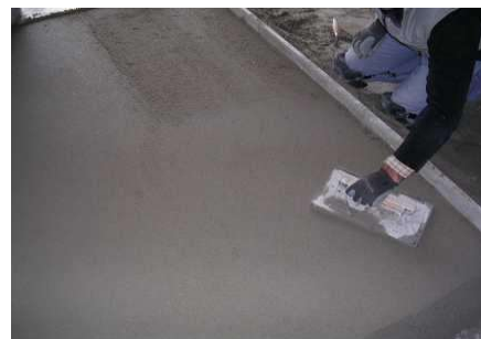
Talochamento da superfície final
