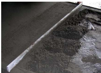
Colocação da argamassa
