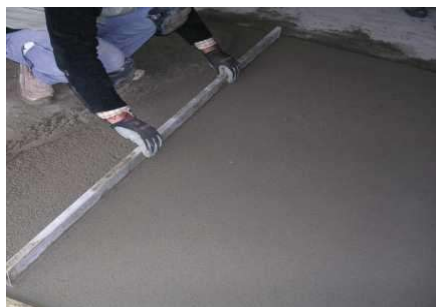
Regularização com régua metálica
