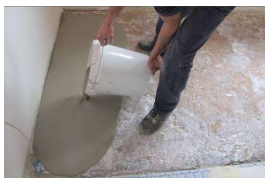
Aplicação do PLAN LEVEL 15/40
