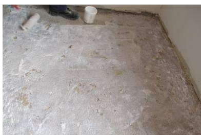
Aplicação do primário MICROART AD 21
