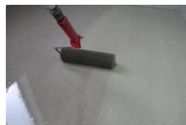
Uniformização da superfície c/ rolo de bicos
