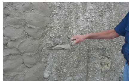
Aplicação manual do B-REPARA FACE R2
