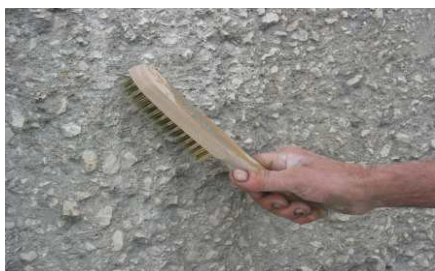
Remoção das matérias desagregadas
