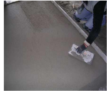
Talochamento da superfície final
