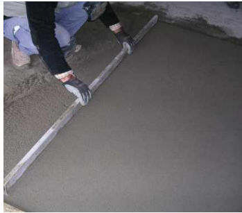
Regularização com régua metálica
