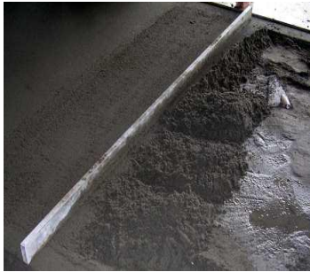
Colocação da argamassa
