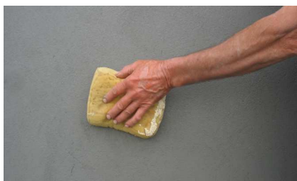
Execução do acabamento areado
