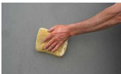
Execução da textura areada
