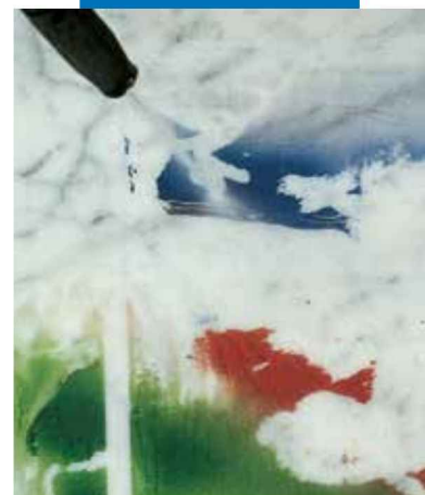
Lavagem com água à pressão, de mármore de Carrara tratado com WallGard Graffiti Barrier
