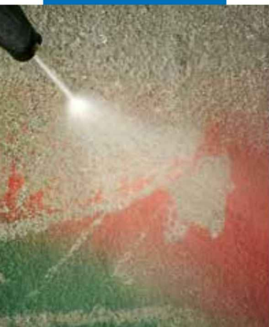
Lavagem com água à pressão, de betão tratado com WallGard Graffiti Barrier
