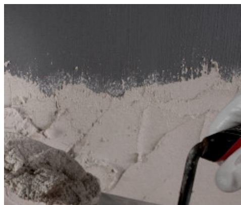
Aplicação de reboco sobre Eco Prim Grip Plus
