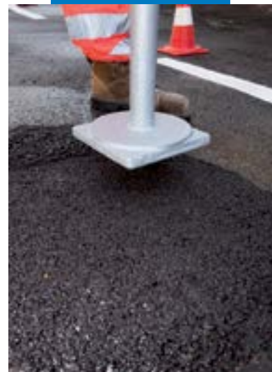
Compactação manual de Mape-Asphalt Repair 0/8
