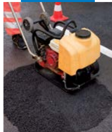
Compactação mecânica de Mape-Asphalt Repair 0/8
