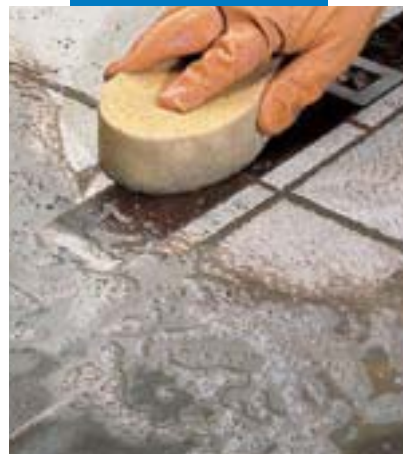
Acabamento de pavimento cerâmico com inserções em madeira com esponja
