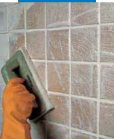
Acabamento de ladrilhos de monocozedura com Scotch-Brite®
