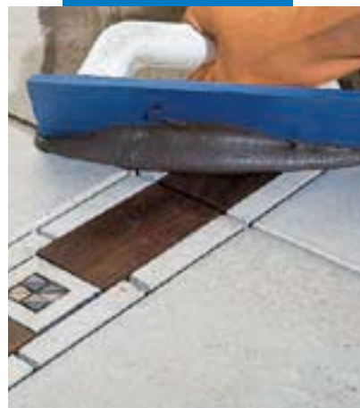
Execução de juntas em pavimento cerâmico inserções em madeira com espátula
