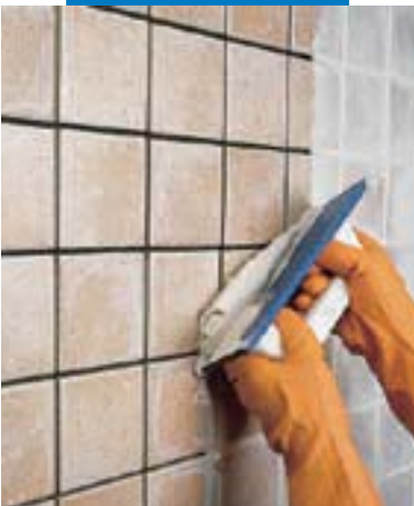
Execução de juntas de revestimento em monocozedura com espátula
