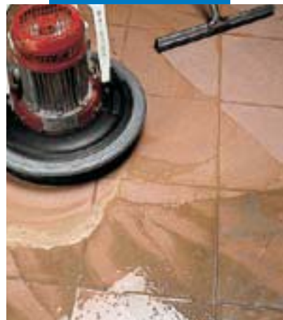
Acabamento de pavimento em porcelanato com monoescova e régua
