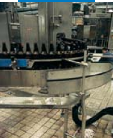
Exemplo de execução de juntas numa cervejaria
