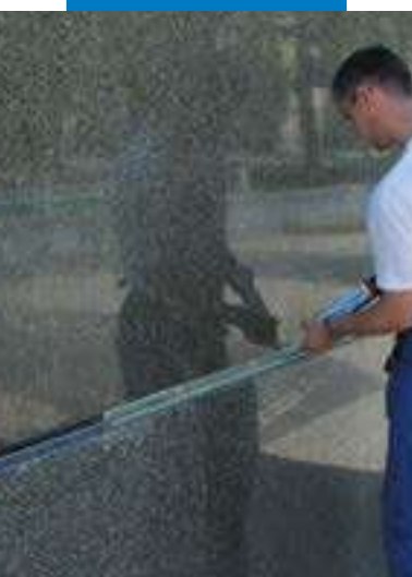
Selagem de uma junta em fachada com Mapesil LM
