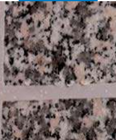
Selagem de revestimento em pedra no exterior
