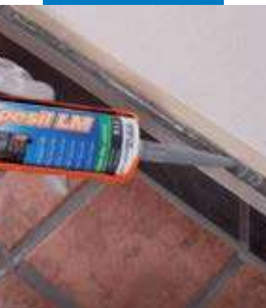
Selagem de revestimento em pedra no interior
