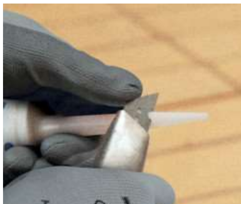
Cortar o bico de acordo com as dimensões da junta
