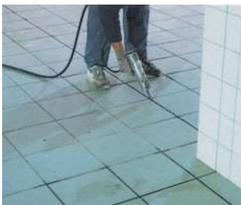
Selagem com Mapefil AC de um pavimento de cerâmica
