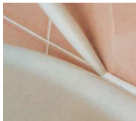
Selagem de sanitários
