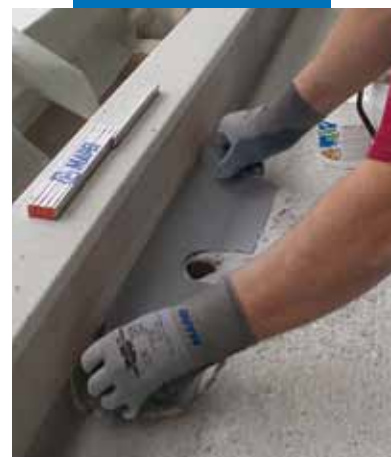
Colocación de banda elástica de Hypalon
