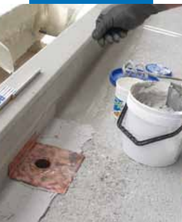
Colocación de collarín y sumidero de cobre
