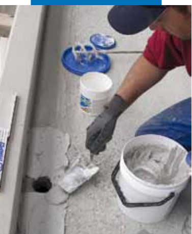
Extensión de Adesilex PG4 mediante paleta
