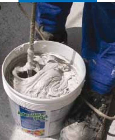
Preparación de la mezcla
