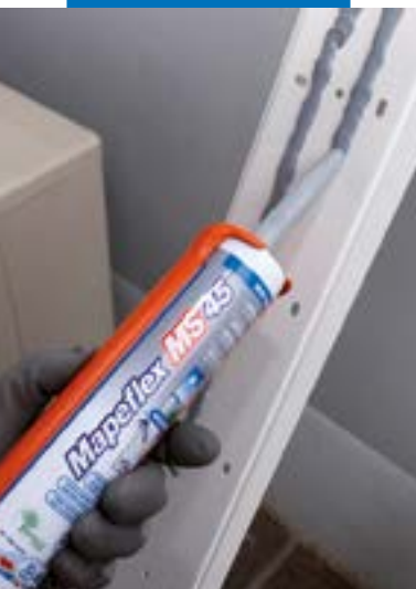
Colagem de perfis em plástico no exterior
