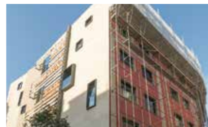
Reabilitação da fachada em edifício residencial da Plaza 8 de Marzo Barcelona, Espanha
