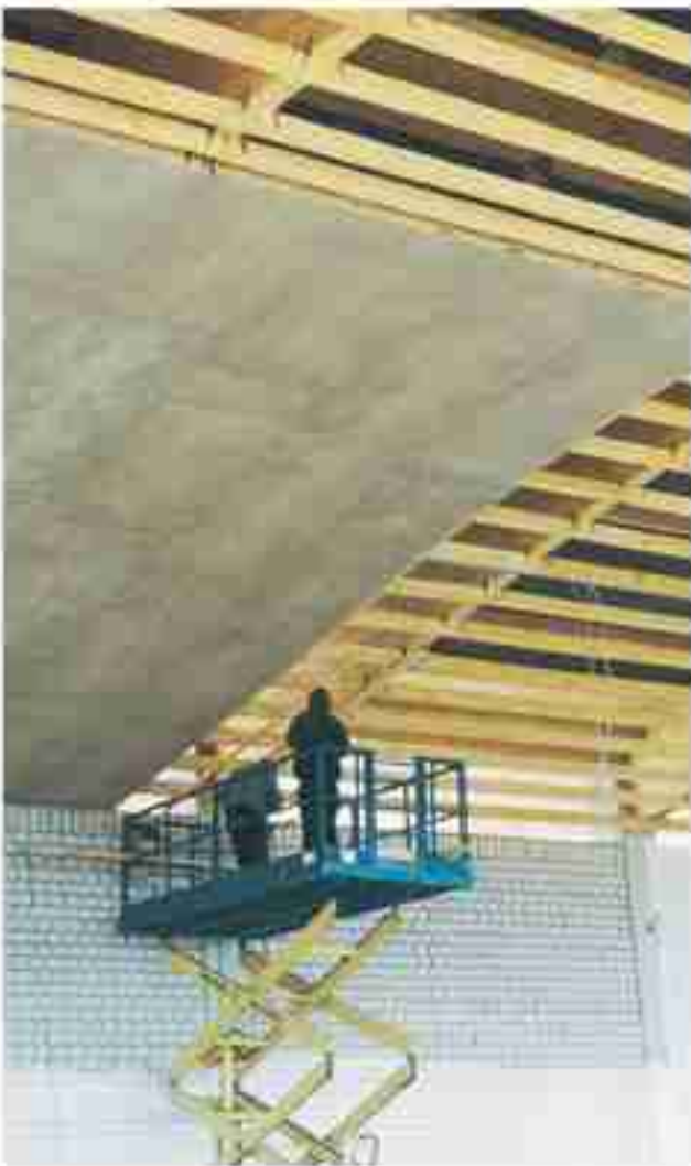
Construcción de techo con Duripanel B1
