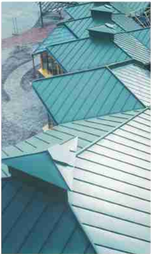
Construcción de tejado incombustible con un soporte integral de Duripanel A2.
