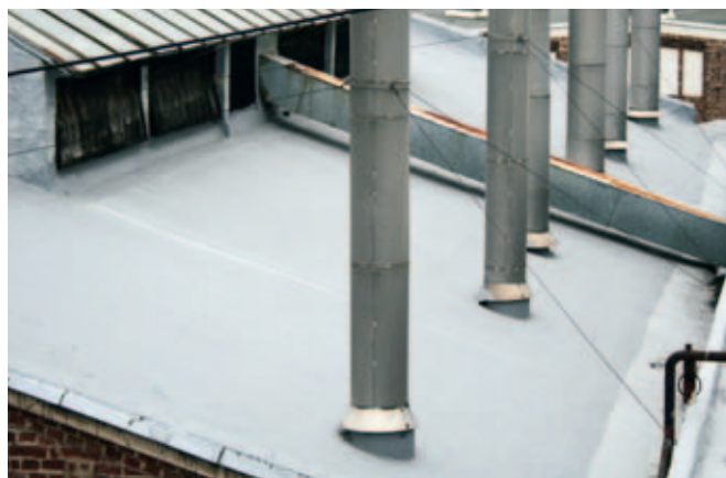
Coberturas industriais com diferentes pontos singulares
