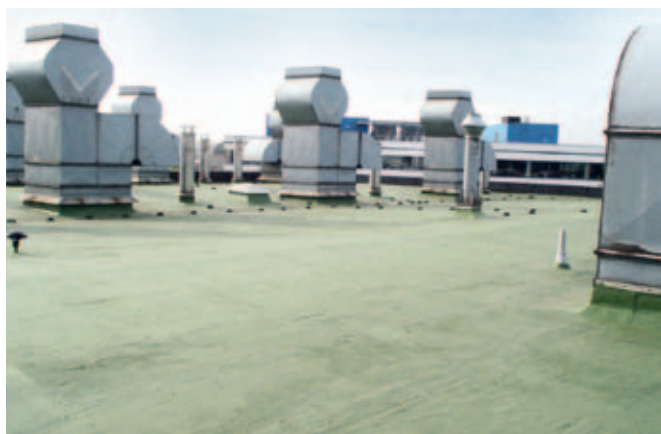
Coberturas industriais com numerosas instalações técnicas
